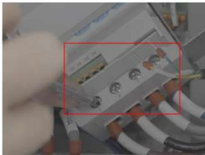
Figura 9-7 Desconexión de los cables de salida L y N
