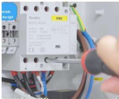
Figura 9-18 Desconexión de los cables L&N
