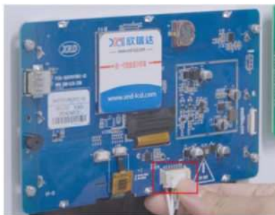
Figura 9-2 Desconexión de los cables de comunicación
