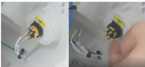
Figura 9-22 Desconexión de los cables de comunicación
