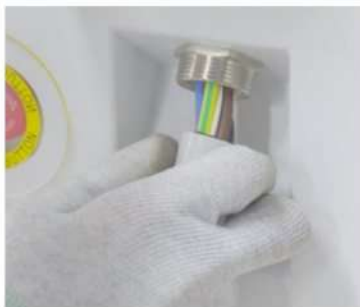
Figura 9-21 Extracción de los cables de carga
