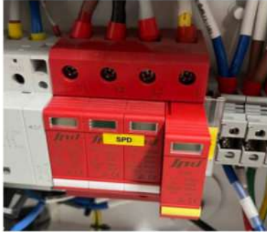
Figura 7-3 Conexión y desconexión de módulos SPD
