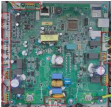
Figura 9-1 Extracción de la antigua unidad de control de la circulación (CCU).
