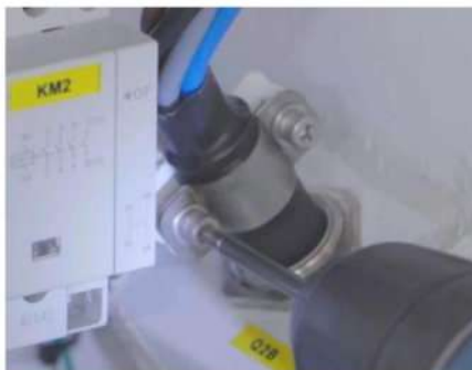
Figura 9-19 Extracción de la abrazadera del cable
