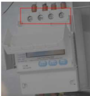
Figura 9-5 Desconexión de los cables de entrada L y N
