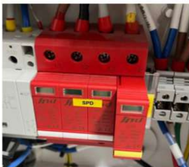
Figura 9-26 Extracción del módulo defectuoso
