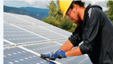
Nunca se ponga de pie sobre las superficies delantera o trasera de un módulo, ni las pise, dañe o arañe. Los módulos rotos no se pueden reparar. Nunca utilice un módulo con el vidrio roto o con el sustrato rasgado.
